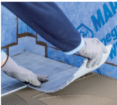
Aanbrengen van de tegels
