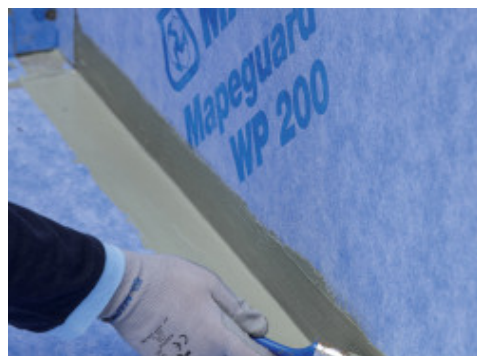
Aanbrengen van Mapeguard WP Adhesive om de voegen in de hoek af te dichten voordat Mapeguard ST wordt aangebracht
