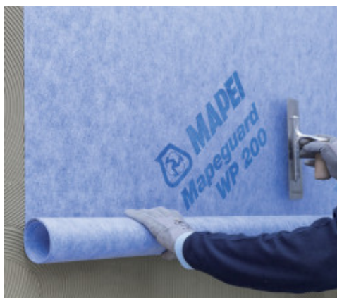
Aanbrengen van Mapeguard WP 200
