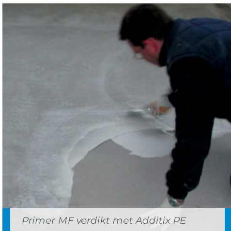
Vullen van een voeg met Primer MF aangevuld met Additix PE
