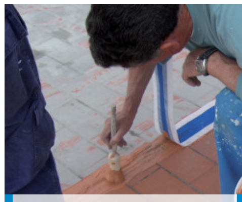
Waterdichting van een scheidingsvoeg met Mapeband Easy bevestigd met Aquaflex Roof
