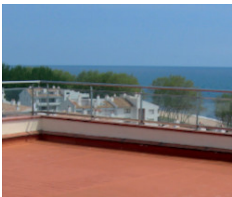
Met Aquaflex Roof waterdicht gemaakt plat dak
