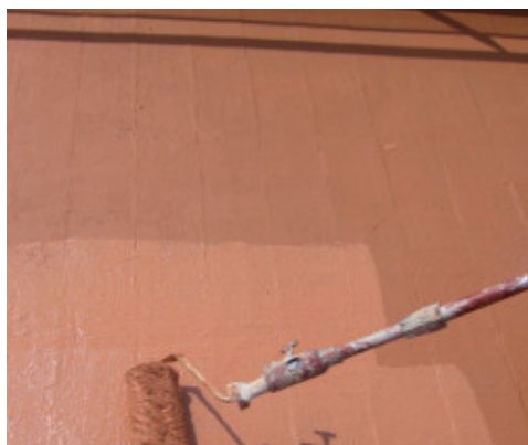
Aanbrengen van Aquaflex Roof met een roller met lange haren
