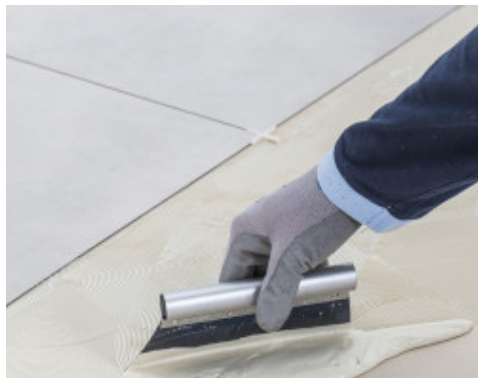
Aanbrengen van Ultrabond Eco 4 LVT en hechten van de LVT met brede voegen en afstandhouders
