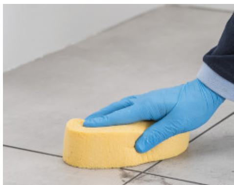
Verwijderen van restanten van Flexcolor 4 LVT met een spons van het oppervlak van de tegels
