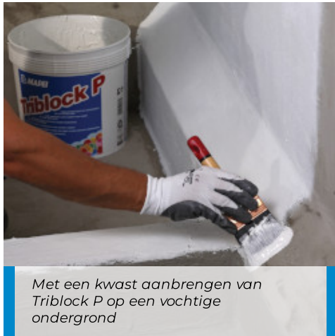
Aanbrengen van Triblock P op de overgang tussen vloer en muur
